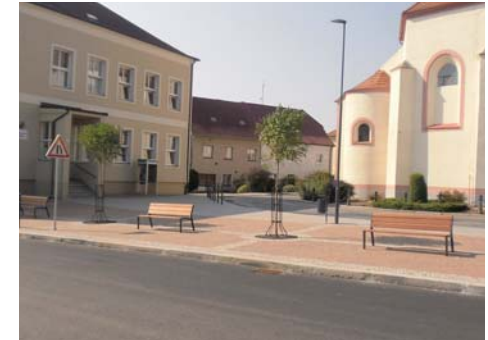
Rekonstrukce chodníků v Rudolfově
