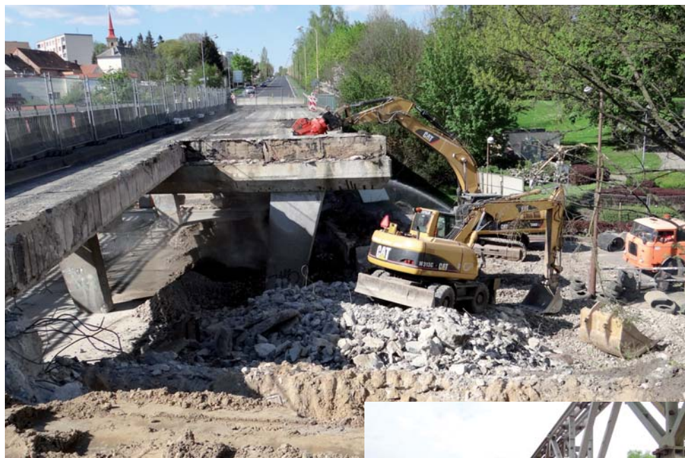
Demoliční práce a mostní porvizorium mostu ev. č. 9-054 přes Moskevskou ulici
